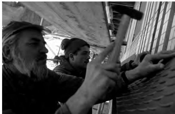
Eternitschindeln werden angeschlagen
