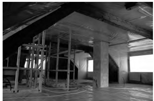
Dachstock isoliert
